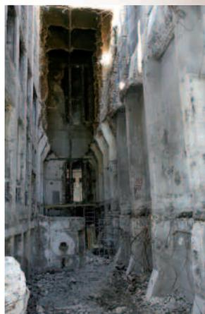
◀ **Déconstruction.** Dans les anciens magasins à farine, il a fallu casser les travées centrales à l'aide d'une pelle à grand bras (30 m). Cette trouée permet de réaliser les nouveaux planchers à structure métal et bac acier (planchers collaborants).
